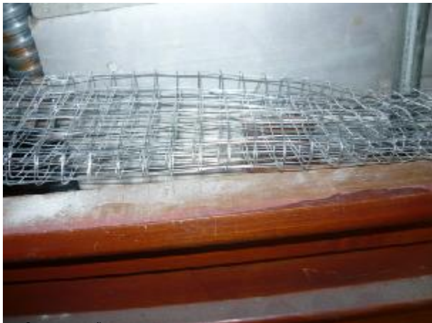
การใช้ตะแกรงลวดในการปิดกั้นเส้นทางหนู
