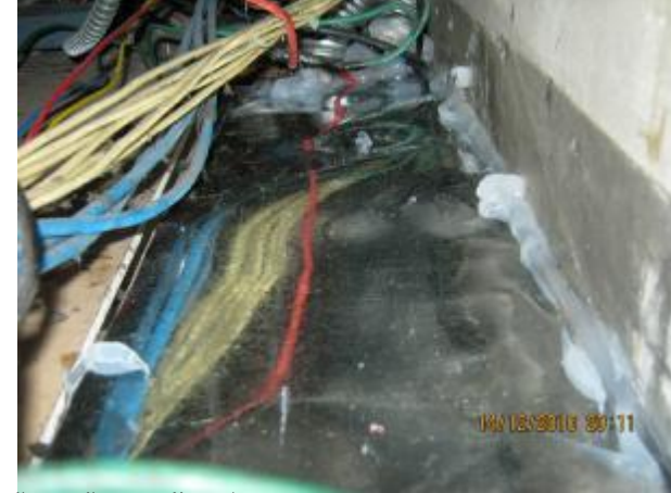
ภาพการปิดเส้นทางด้วยแผ่นสังกะสี
