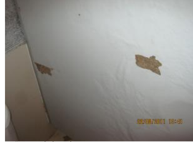
สภาพที่ถูกปลวกเข้าทำลายเฟอร์นิเจอร์
