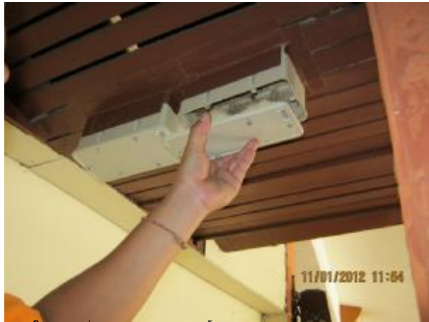
การติดตั้งสถานีปลวกในกรณีที่มีปลวกมาก จะติดตั้งสถานีปลวกมากกว่า 1 สถานี
